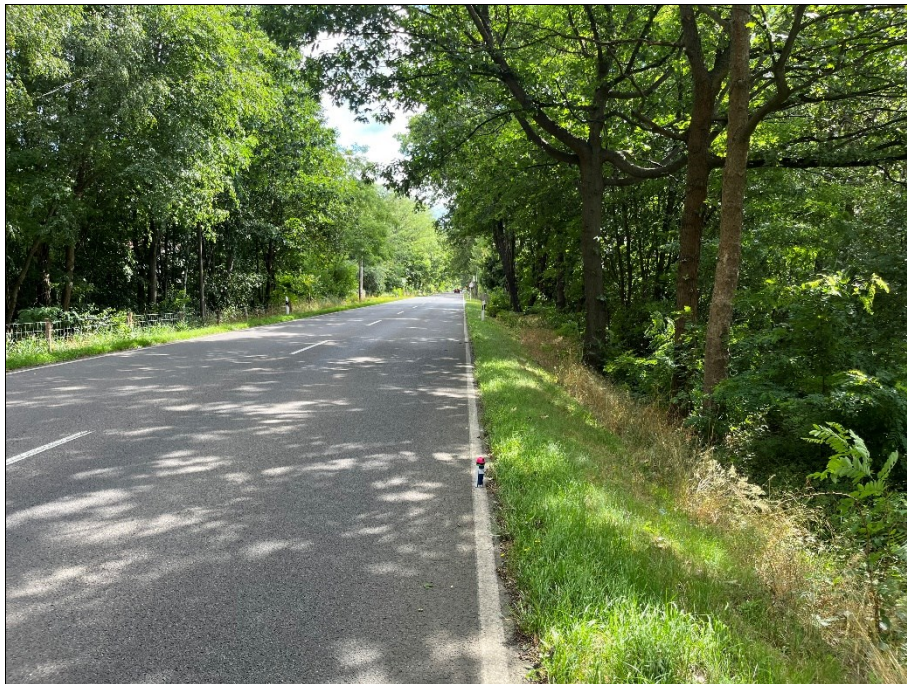
Abbildung 3: Bundesstraße B 156 mit Bearbeitungsgebiet 9, südliche Böschung (Blick Richtung E).
