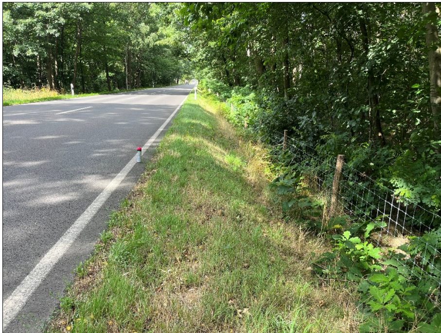
Abbildung 4: Bundesstraße B 156 mit Bearbeitungsgebiet 10, nördliche Böschung (Blick W).
