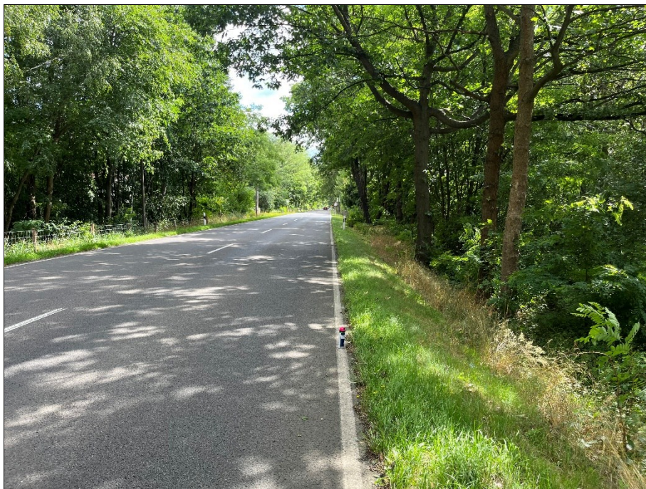
Abbildung 5: Bundesstraße B 156 mit Bearbeitungsgebiet 11, südliche Böschung (Blick Richtung E).
